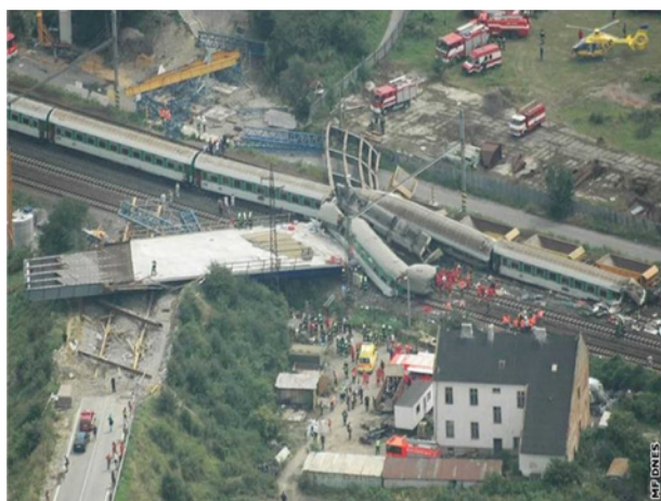
Obr. 2: Náraz vlaku do zříceného mostu
